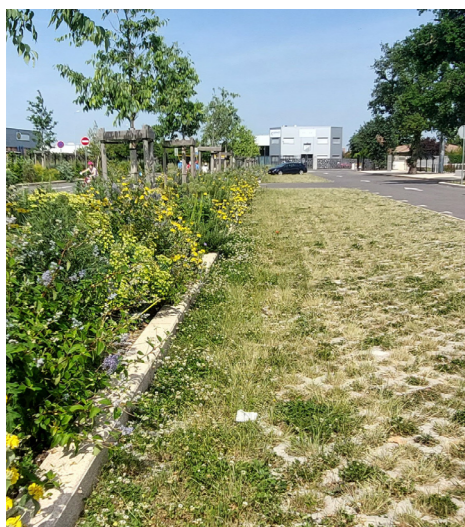
Alvéoles béton joints enherbés
