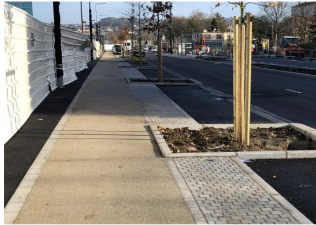
Bande piétonne en stabilisé renforcé
