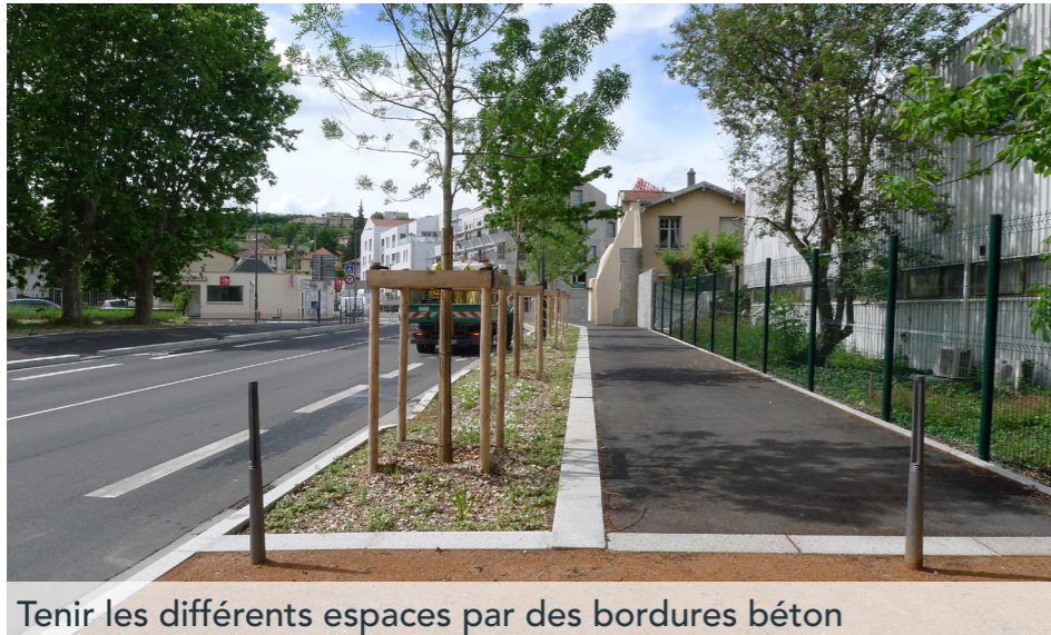
Bande piétonne en stabilisé renforcé
